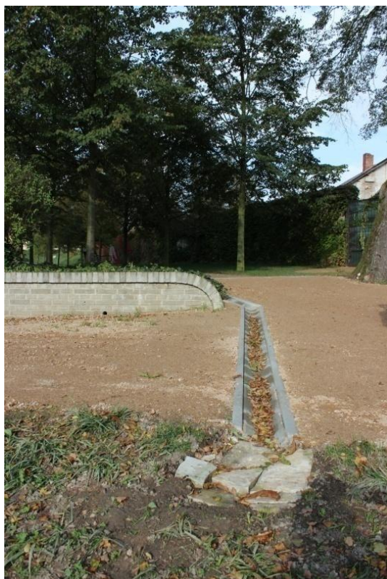
Obrázek 46: Svodnice - současný stav (zdroj: autor)
