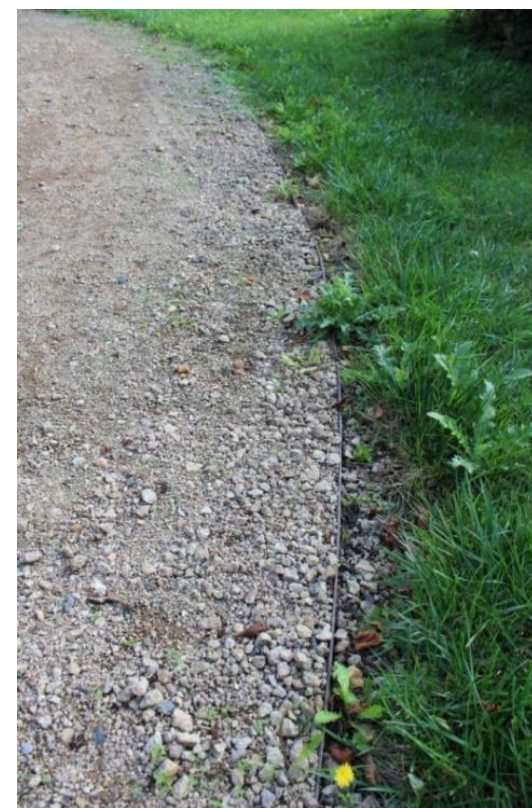
Obrázek 44: Obrubníky - současný stav (zdroj: autor)
