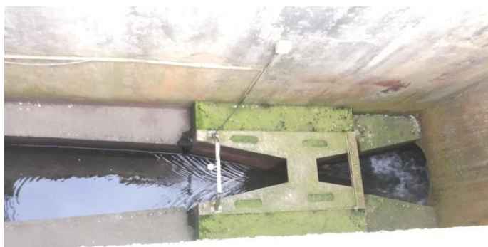
Obr. 11 – Parshallový žlab, (Alice V.)
