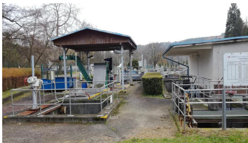
Obr. 6 – Vlevo česle značky Fontana, vpravo náhradní česle značky DORR, (Alice V.)
