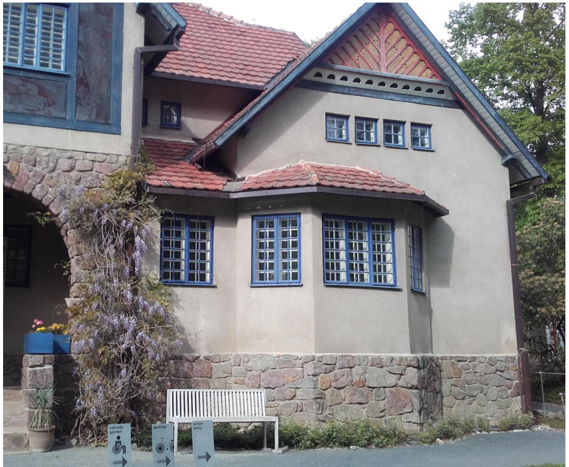
Obr. 103 Pohled na arkýřové okno
