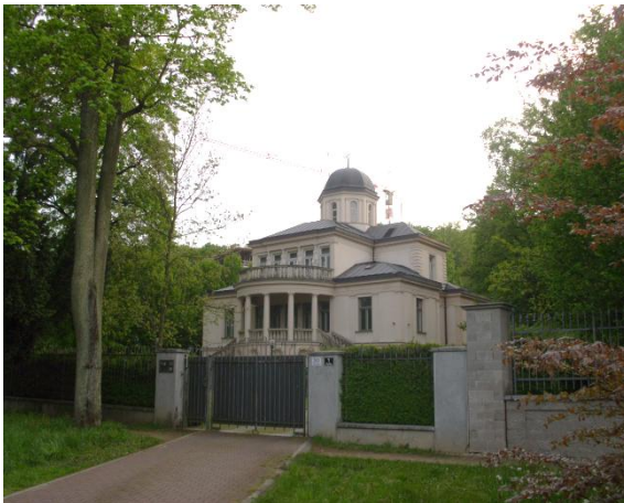
Obr. 34 Vila Heinricha a Mauricie Fontaineových von Felsenbrunn od Moritze Kellnera von Brunheima, 1879-1880
