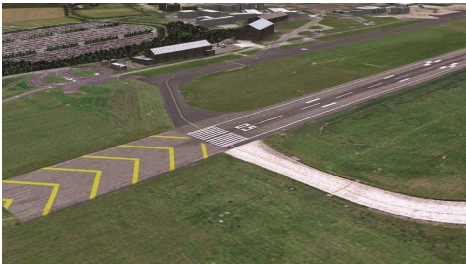
Obr. 2 Dojazdová dráha značená žltými šípkami [3]
