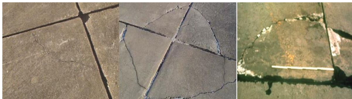
Obr. 12 Rohové zlomy na betónových vozovkách [10]
