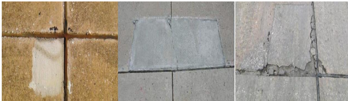
Obr. 16 Záplaty na betónových vozovkách [10]
