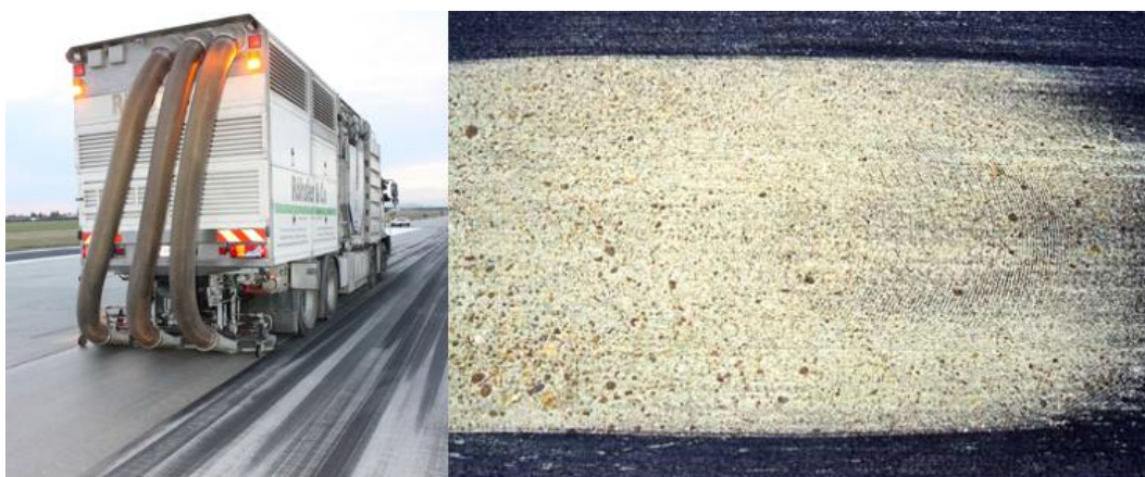
Obr. 22 Zariadenie a výsledok po odstránení gúmy [30]
