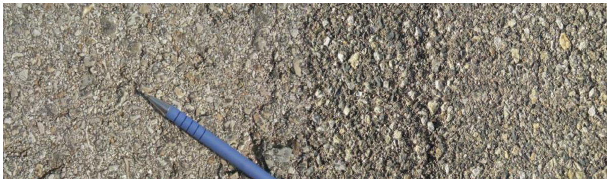
Obr. 13 Rozvinutie na asfaltových vozovkách [10]
