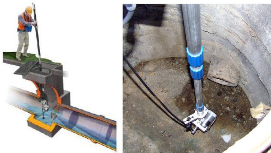
Obr. 9.5 Příklad vizuální kontroly pomocí šachtové kamery [21][24]
