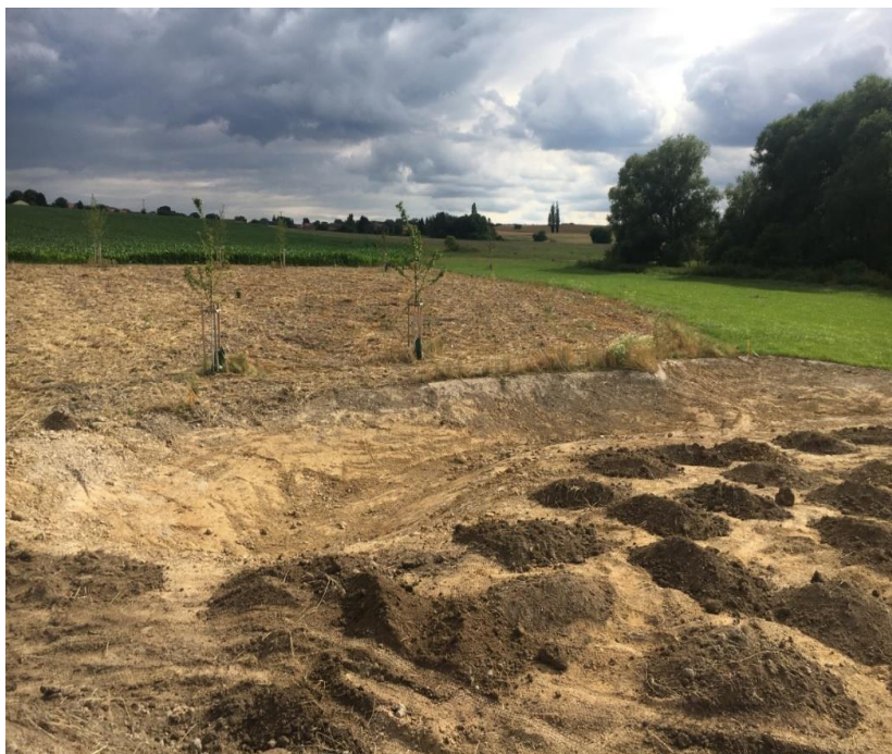
Foto č.5: Rozvoz zeminy na založení louky
