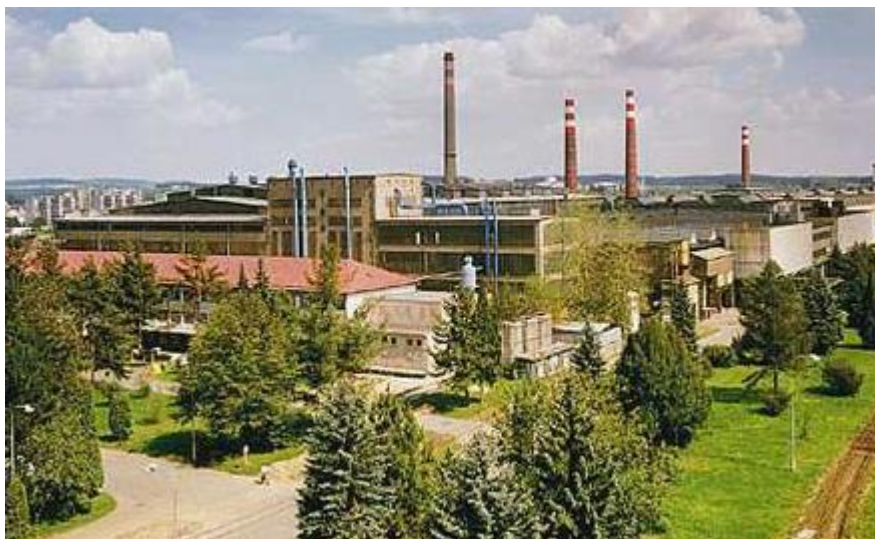
Obr. 10 Pohled na halu H9 – Metalurgie [9].
