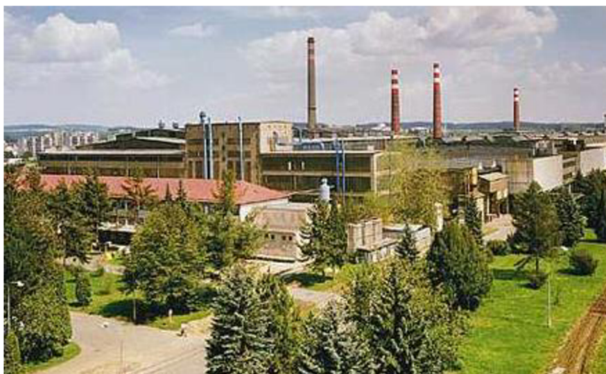
Obr. 10 Pohled na halu H9 – Metalurgie [9].
