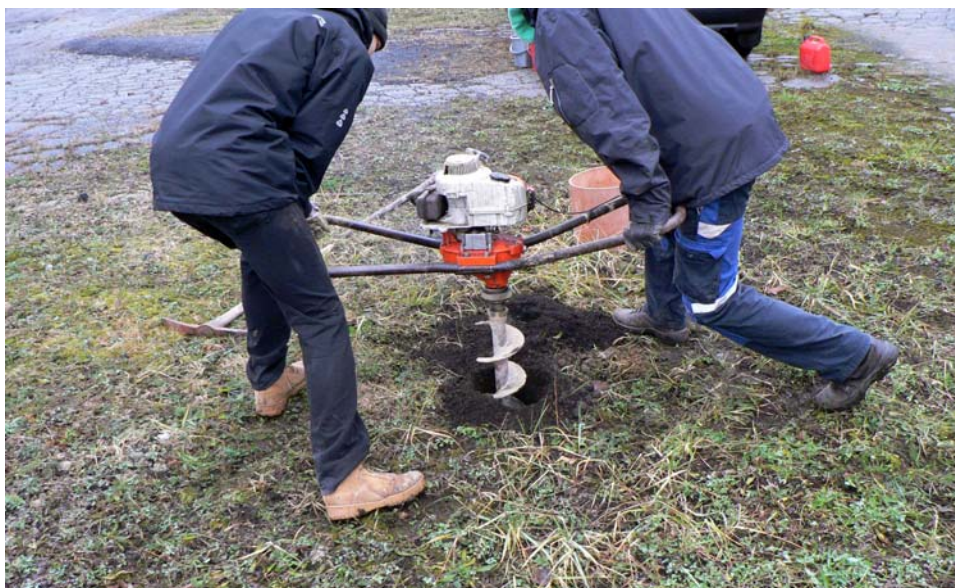
Obrázek č. 11: Vrtání průzkumné sondy o průměru 150 mm
