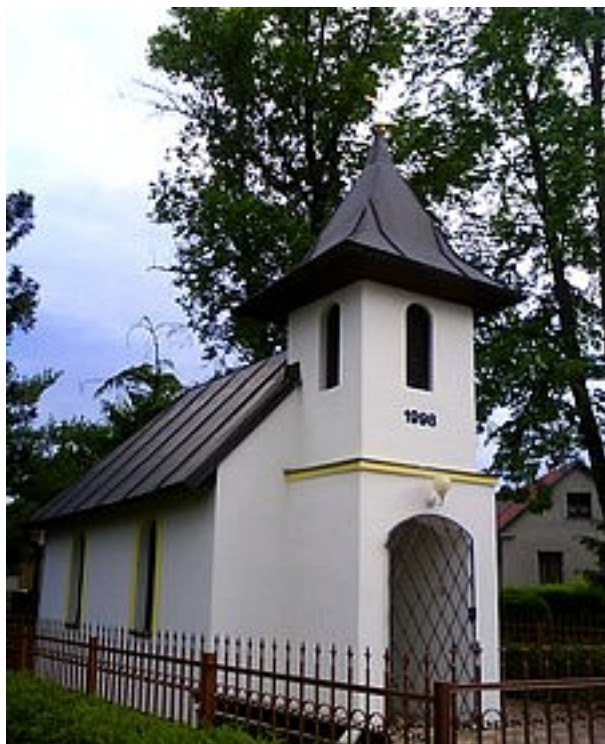
Fotografie 48-Kaplička se samostatným prostorem a zvoničkou. Zdroj: vlastní zpracování.(CC)BY-NC
