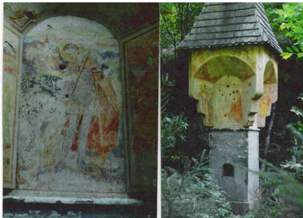
Obrázek 28- Kaplička Kozlí před opravou. Zdroj: Návštěva památkové péče v Benešově.
