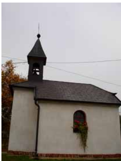
Fotografie 19-Zděná kaplička v obci Petřiny. Zdroj: vlastní zpracování (CC)BY-NC.
