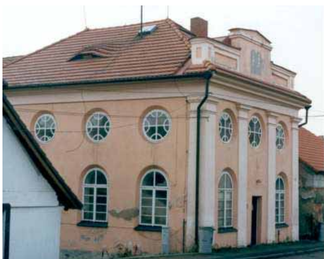
Fotografie 12- Synagoga před rekonstrukcí. Zdroj: Návštěva Posázaví o.p.s.
