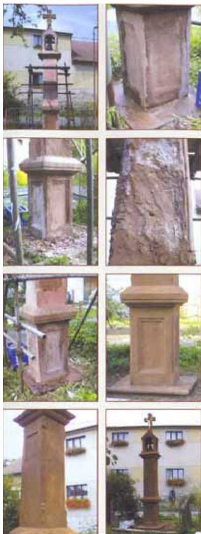
Obrázek 5-Postup při opravě památkově chráněné zvoničky v Českém Šternberku. Zdroj: Informační brožura CHOPOS
