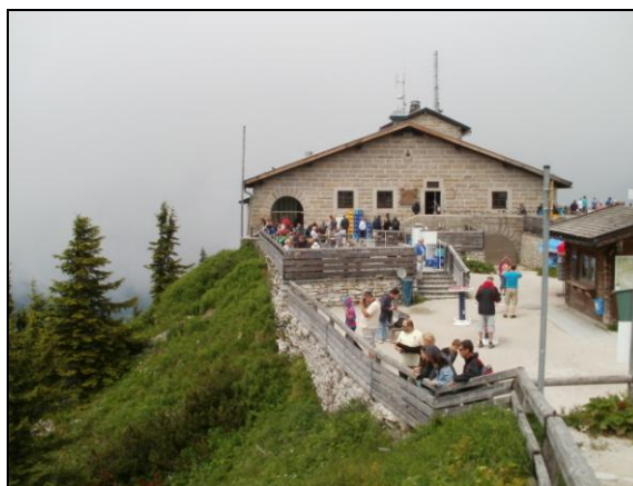
Obrázek 3: Budova Orlího hnízda s terasou. Zdroj: autor, 2014
