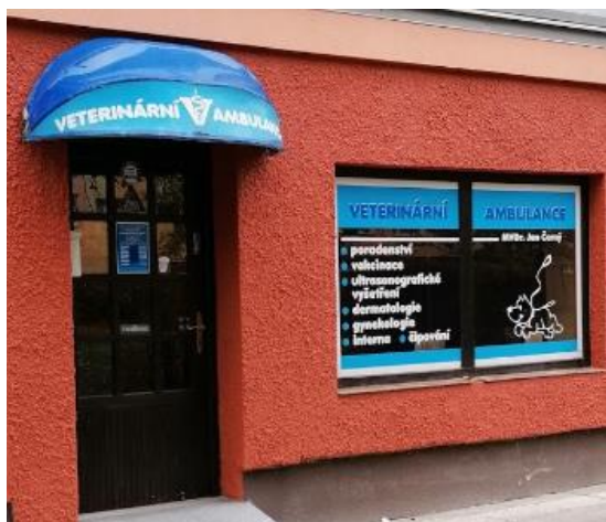
Obrázek 23 - Budova Veterinární ambulance MVDr. Jan Černý 57
