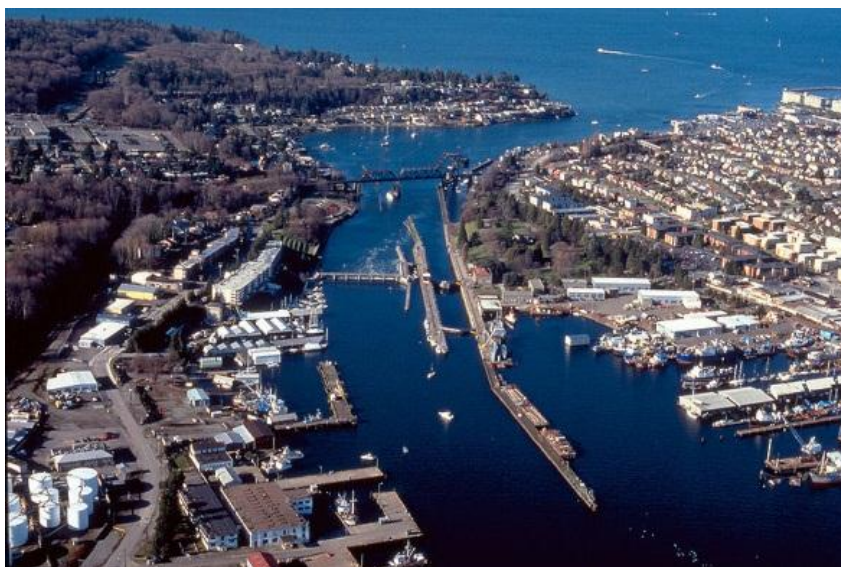
Obr. 4 Letecký pohled na lodní zámky a lodní kanál Washingtonského Jezera [8]
