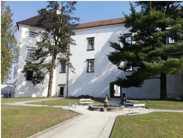
Obr. 17: pohled ze zahrady na Velké arkády, v pozadí Pinus strobus a Pseudotsuga menziesii var. Glauca (zdroj: vlastní)
