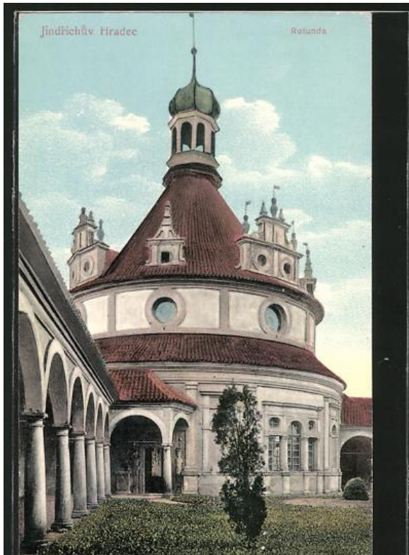
Obr. 11: pohled na Rondel ze strany levého loubí, 1910 (zdroj: www.aukce-pohlednic.com )
