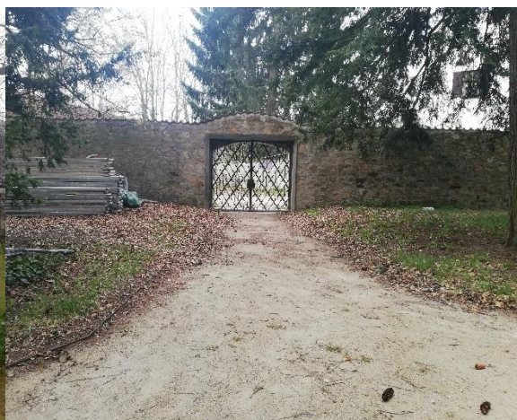
Obr. 28: pohled na vstupní bránu západní části zahrady (zdroj: vlastní)
