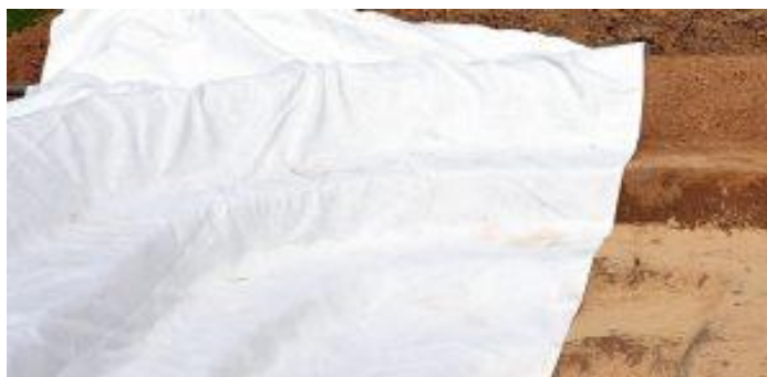
Obrázek 14: Pokládka geotextílie [27]
