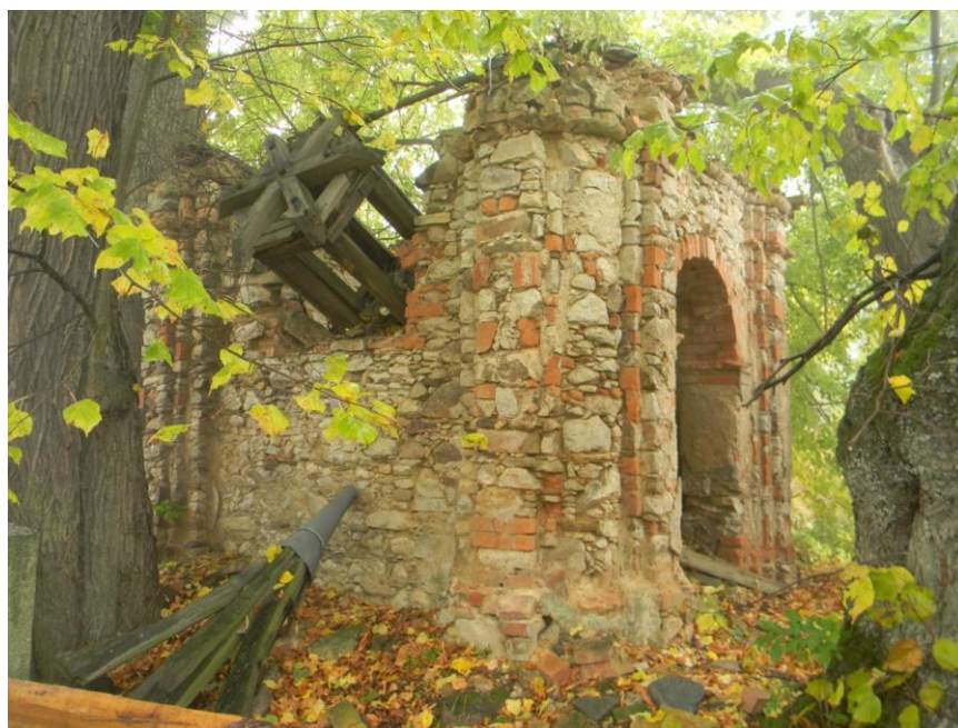
4. Chátrající kaplička stojící za hřbitovem na okraji obce Kostelní Bříza.
