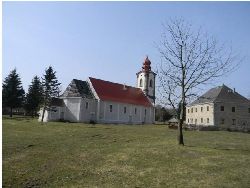
1. Kostel Nejsvětější Trojice v obci Nová Ves prochází v současné době kompletní opravou.
