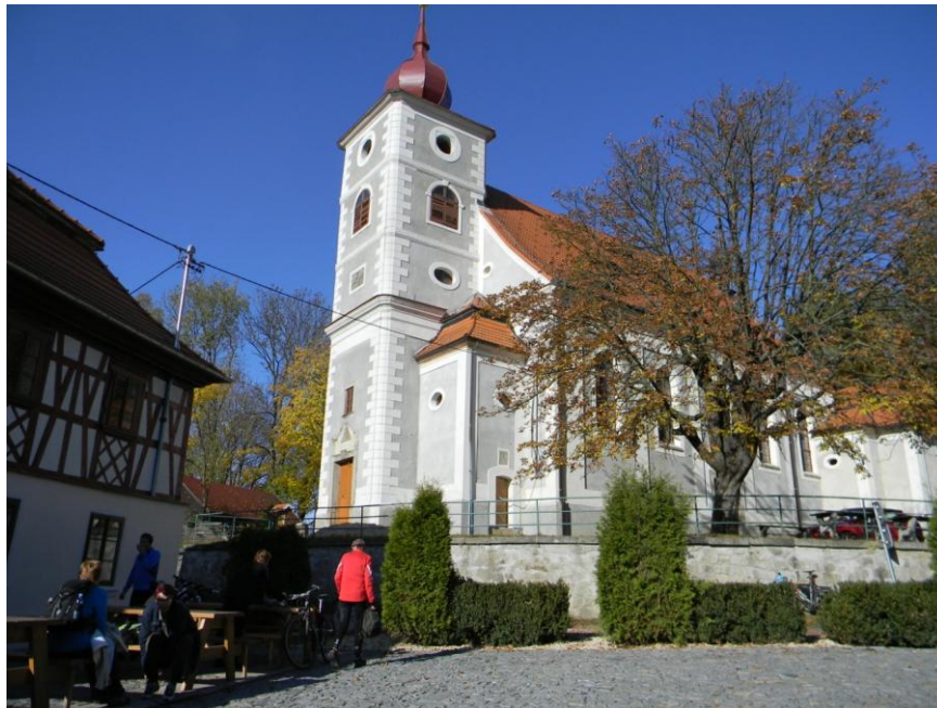
1. Kostel svatého Petra a Pavla v Kostelní Bříze - prochází celkovou opravou.
