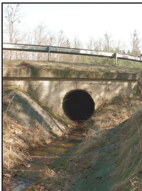
Obr. č. 3: Trubní propust Poříčany 1
