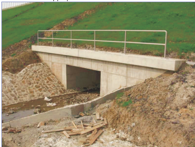
Obr. č. 5: Betonový propustek.
