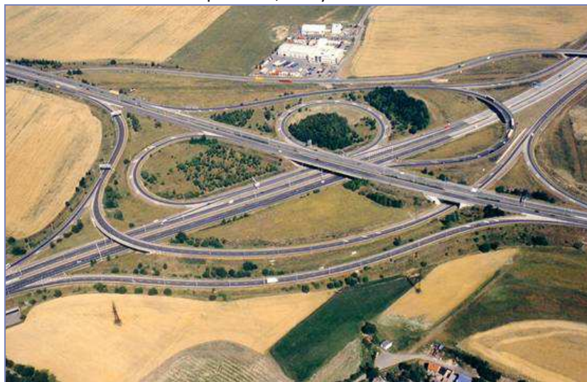
Obr. č. 14: Dálnice D5 v provozu, nultý km.
