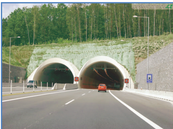
Obr. č. 19: Dálniční tunel Valík.
