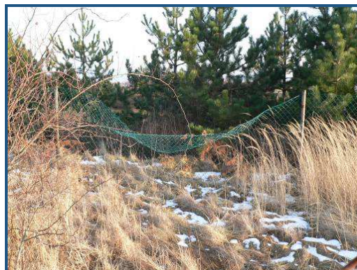
Obr. č. 11 - Příklad poškození plocení v dolní části.
