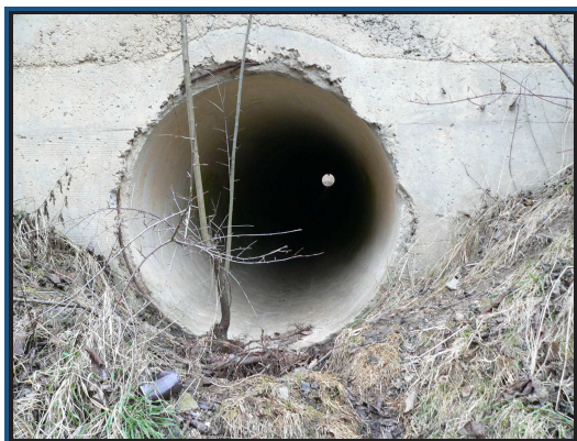
Obr. č. 1: Trubní propust Loděděníce 1
