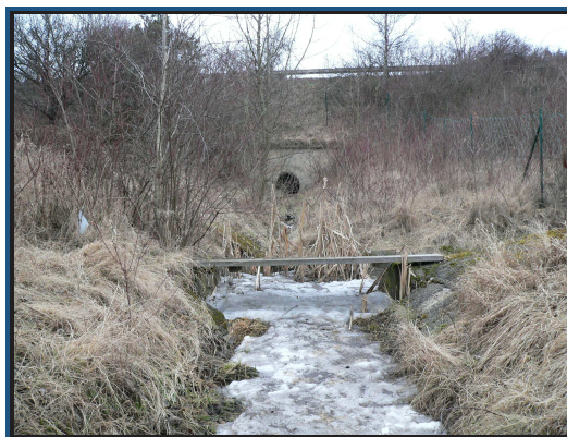
Obr. č. 1: Trubní propust Loděnice 2
