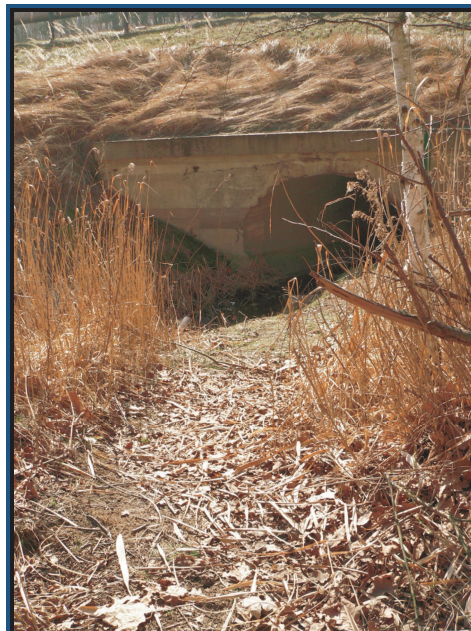
Obr. č. 3: Trubní propust Poříčany 2
