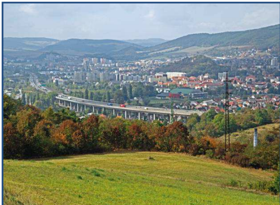
Obr. č. 15: Dálniční most přes řeku Berouнку.
