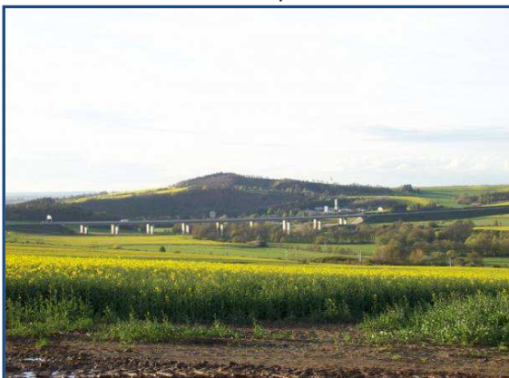
Obr. č. 16: Dálniční most přes řeku Úslavu.
