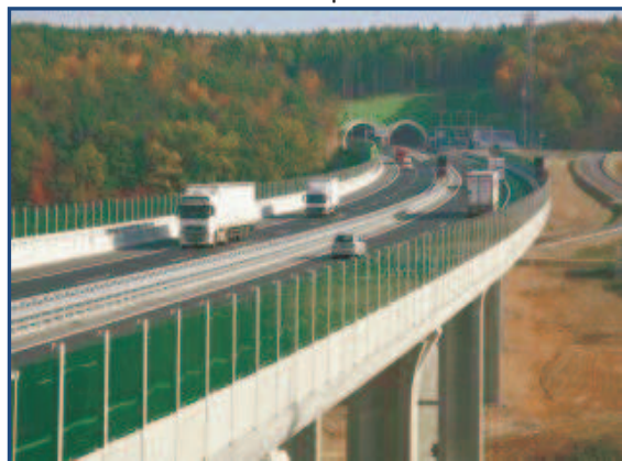
Obr. č. 17: Dálniční most přes řeku Úhlavu.
