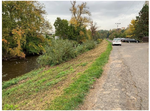
Obr. 23 - Opevnění Chrudimky - ohumusování a osetí (foto autor)
