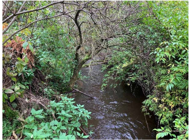
Obr. 26 - Opevnění náhon - současný stav (foto autor)
