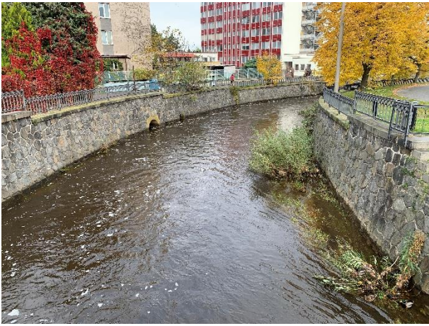
Obr. 22 - Opevnění Chrudimky - nábrežní stěny (foto autor)
