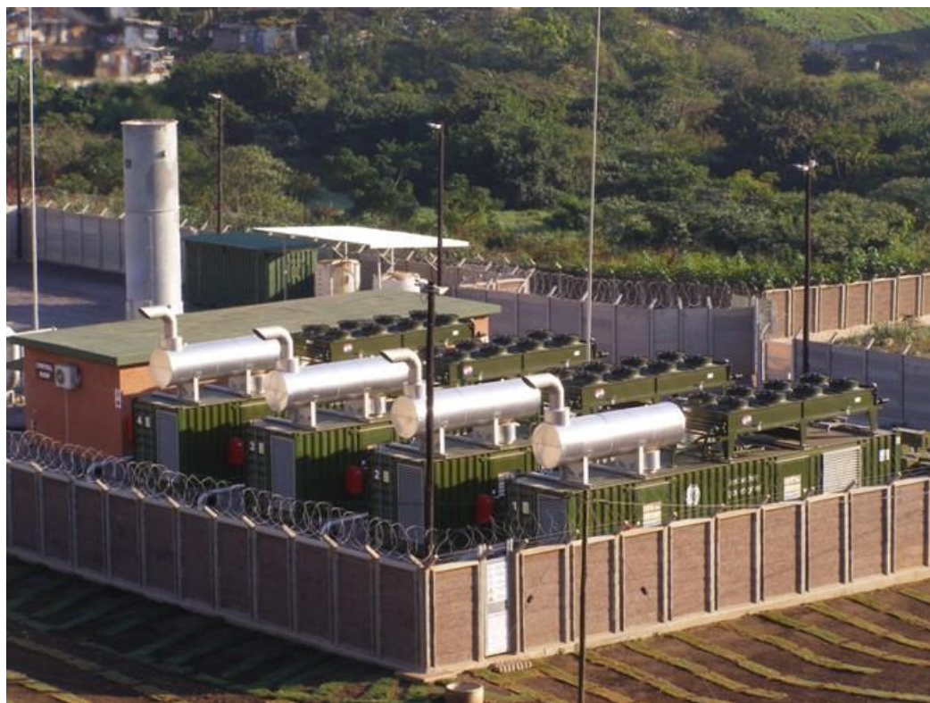
Obr. 7 BPS na využívanie skládkového plynu
