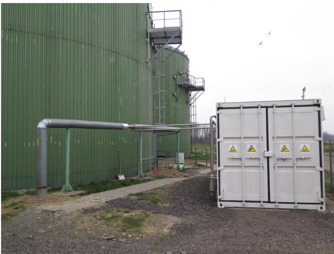
Obr. 21 Pripojenie kontajneru membránovej separácie k potrubiu fermentoru BPS[20]
