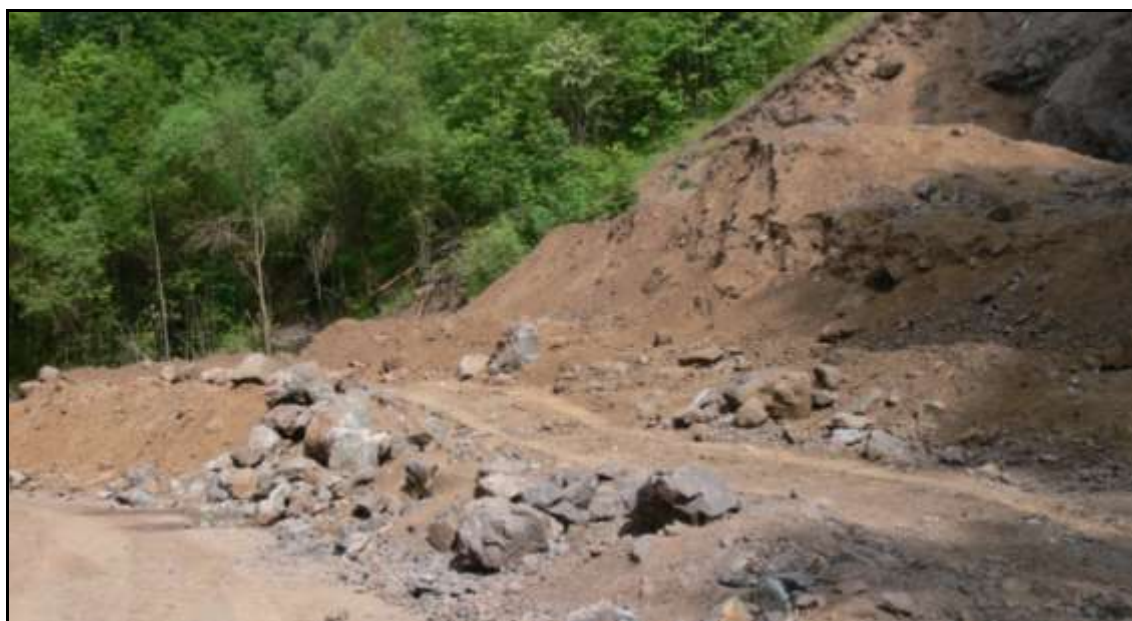
Obrázek č. 4.1.8.: Pohled na lomovou stěnu lokality Votrubcův lom na Kozákově.
