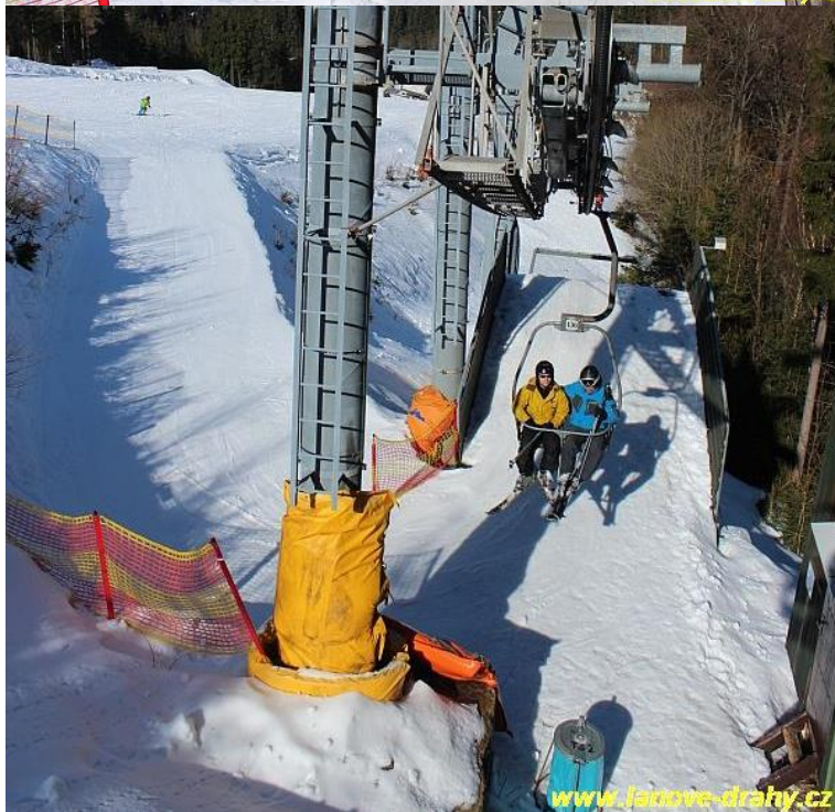
Obr. 48 Horní stanice lanovky „E“ ( http://www.lanove-drahy.cz/fotogalerie/fotky/planv/planvn78.jpg )
