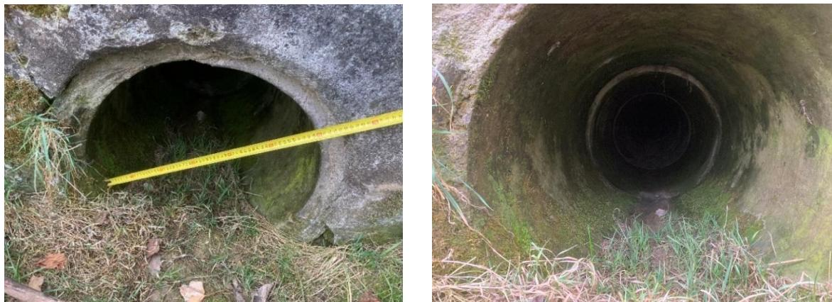
Obr. 61 Potrubí DN 600 v místě KB1 [1]
