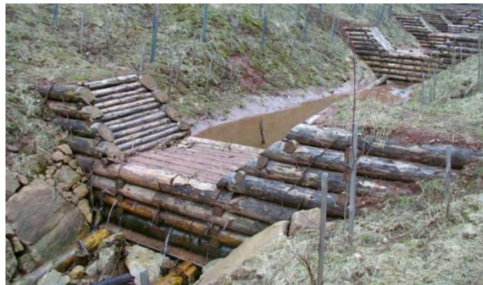
Obr. 23 Příklad soustavy konsolidačních srubových přehrážek ze srubové klatiny [28]
