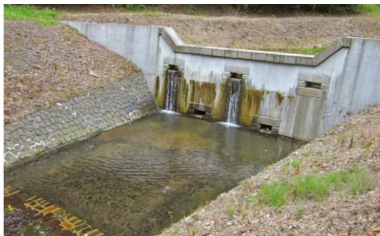
Obr. 22 Příklad betonové retenční přehrážky s průceznými otvory ve dvou úrovních.
