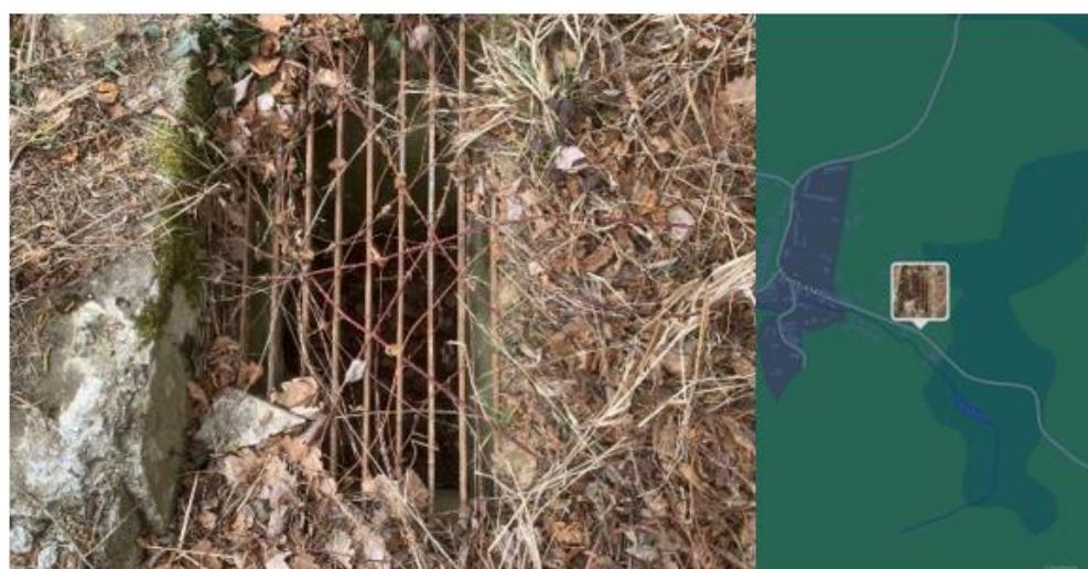
**Obr. 17 Propustek napojující povrchový odtok části KP2 do místa KB2**
