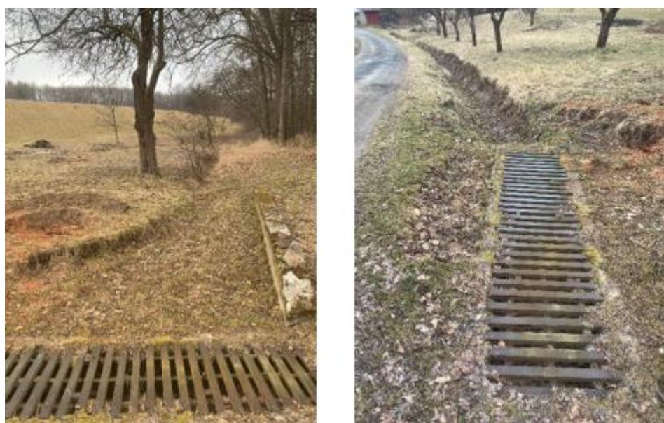
Obr. 29 Záchytný žlab, do kterého proudí soustředěný odtok KP3. Žlab následně přechází v příkop. Zároveň se jedná o území KB3 [1]
