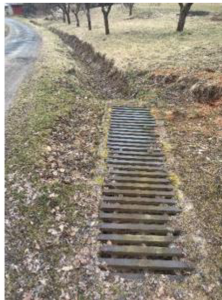
Obr. 29 Záchytný žlab, do kterého proudí soustředěný odtok KP3. Žlab následně přechází v příkop. Zároveň se jedná o území KB3 [1]
