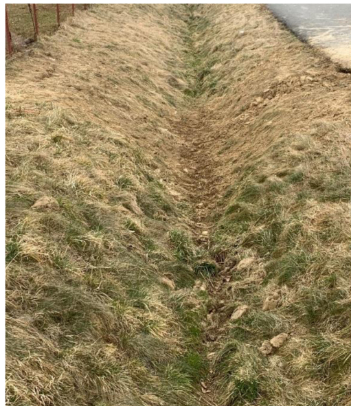
Obr. 60 Svodný příkop v místě KB1 ( b=0,9 m, B=1,6 m, h=0,55 m, přibližné i=3 %) [1]
