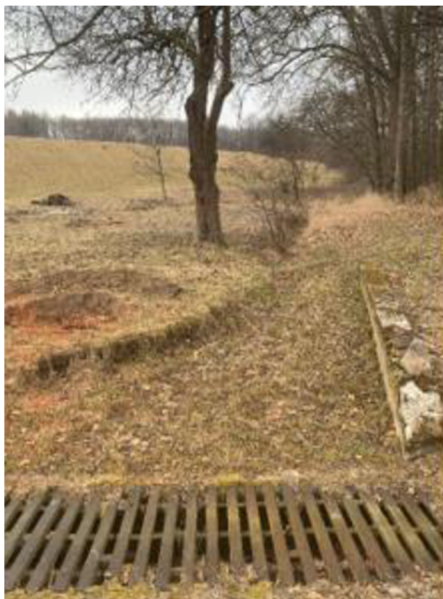
Obr. 29 Záchytný žlab, do kterého proudí soustředěný odtok KP3. Žlab následně přechází v příkop. Zároveň se jedná o území KB3 [1]
