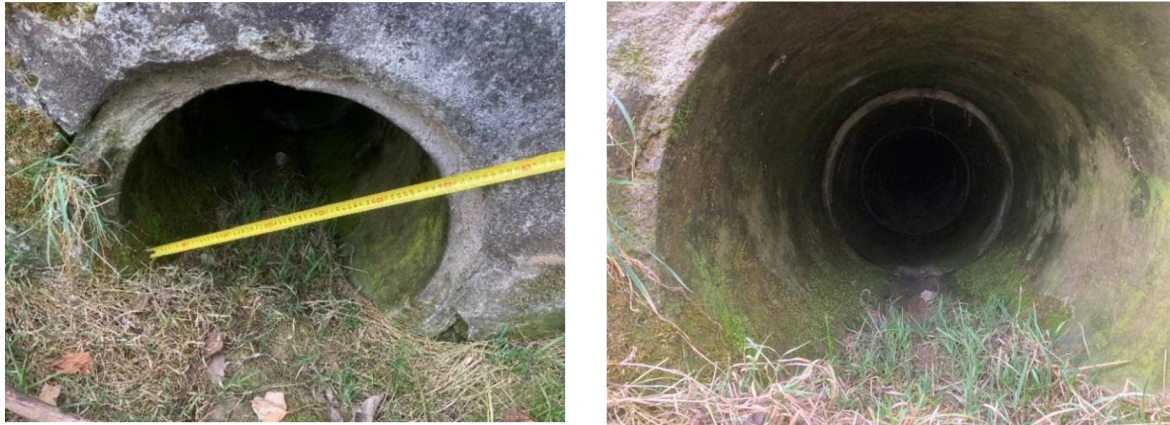
Obr. 61 Potrubí DN 600 v místě KB1 [1]
