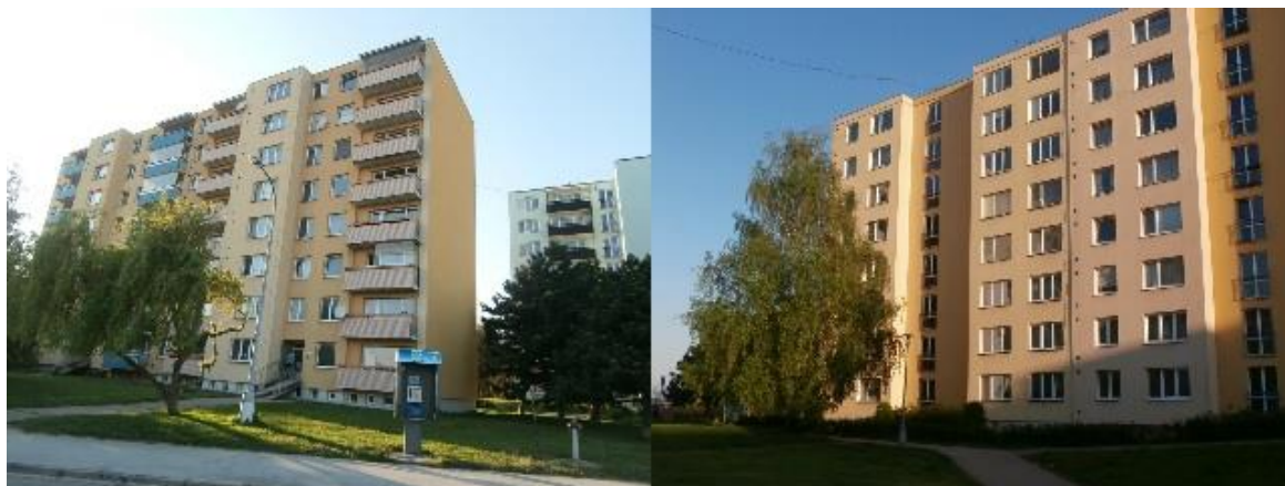
Obr. č. 8: Bytový dům na ulici Rotreklova, č. o. 7 [foto autor]
