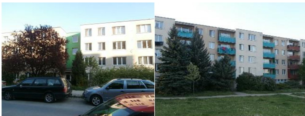
Obr. č. 7: Bytový dům na ulici Popelákova, č. o. 19 [foto autor]
