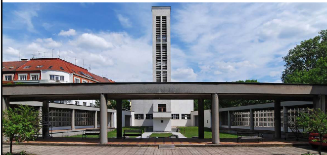
obr. č.18: kolumbárium, věž se zvonici - Ambrožův sbor Církve československé husitské v Hradci Králové autor: Petr Šmídek 2012 (archiweb.cz 1997)
