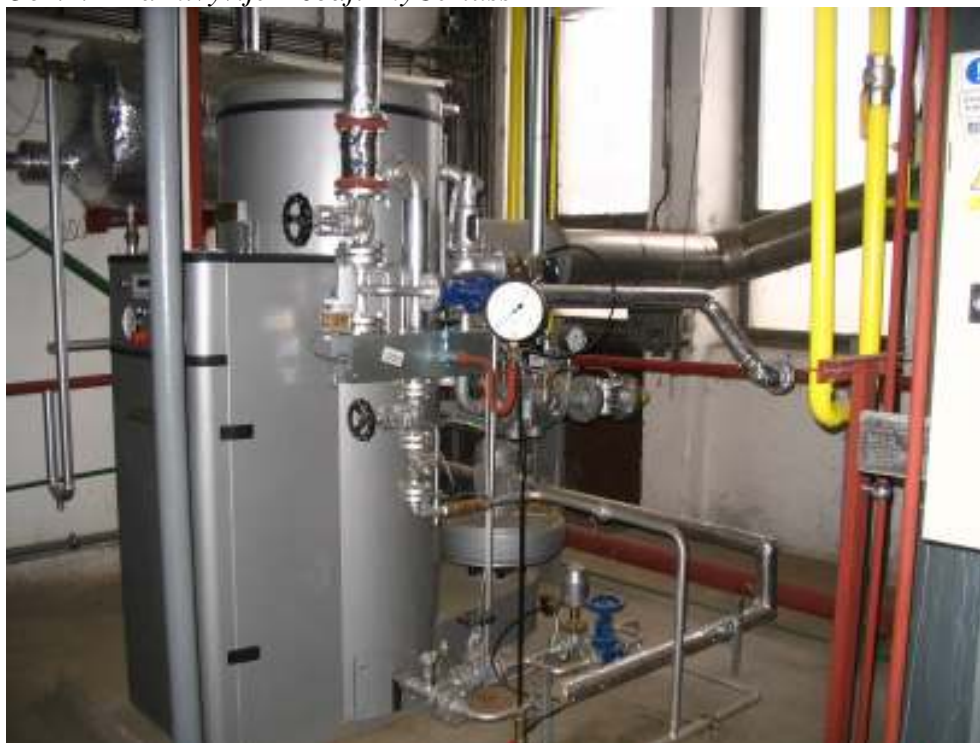
Obr. 2.2 – Parní vyvíje č od firmy Certuss
