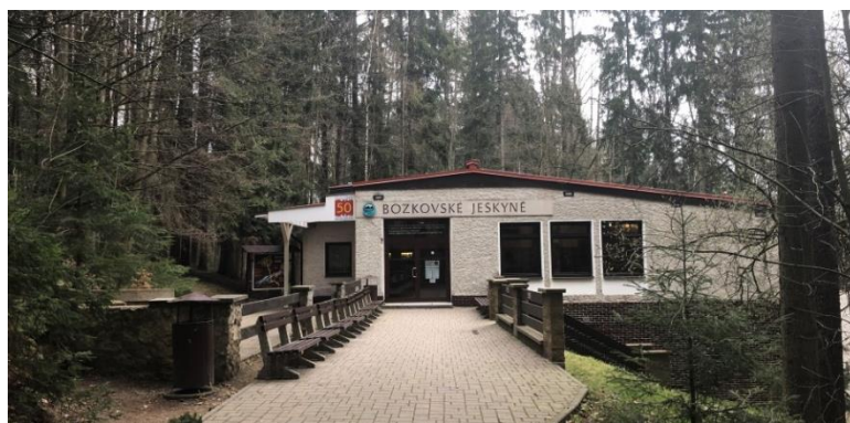
Obrázek 11 - Provozní budova Bozkovských dolomitových jeskyní. Vlastní zdroj.
