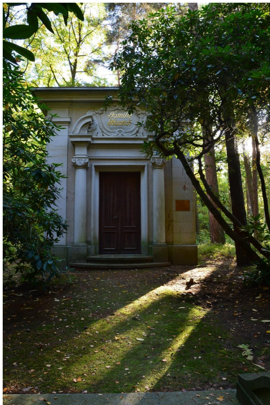
Obrázek 24. Hrobka rodiny Hantichů (zdroj: autor práce 2023).
