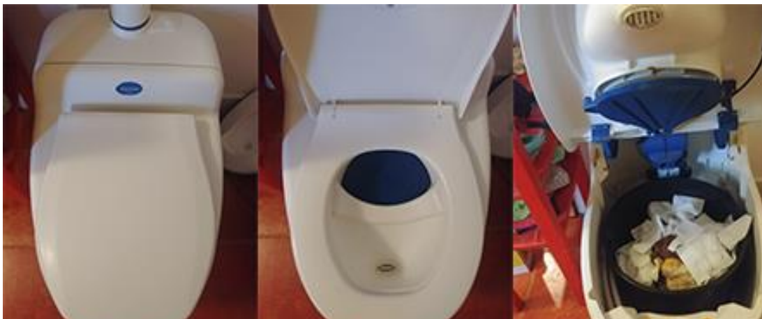
Obrázek 10: Záchod značky Separett, vyroben z plastu, má horní odvod vzduchu sloužící k odvětrávání. První obrázek zavřené toalety. Na druhém obrázku je separace moči a na třetím vnitřek záchodu (fotografie autor, 2020).
