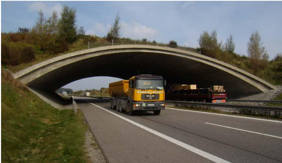
Obr. č. 11: Nadchod – most přes komunikaci (Anděl et al. 2010)
