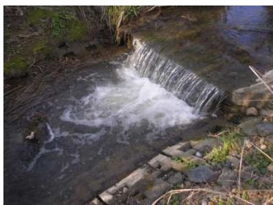
Obrázek 27 Etapa II. jízek na ř. km 0,157 (Tůmová, 04/2010)
