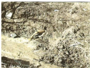
Obrázek 18 Detail pravobřežní drenážní výusti po vyndání opevnění úsek pod sídlem Trní (CIFA, 2006)
