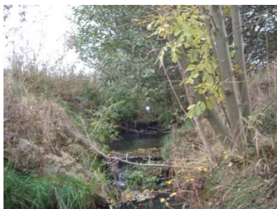
Obrázek 24 Etapa I. Měčínka nad soutokem příčné objekty (Tůmová, 10/2009)
