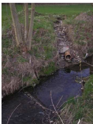
Obrázek 38 Etapa III. Pod Nedaničkami dřevěný prah, v pozadí amatérské odvodnění soukromých pozemků (Tůmová, 04/2010)
