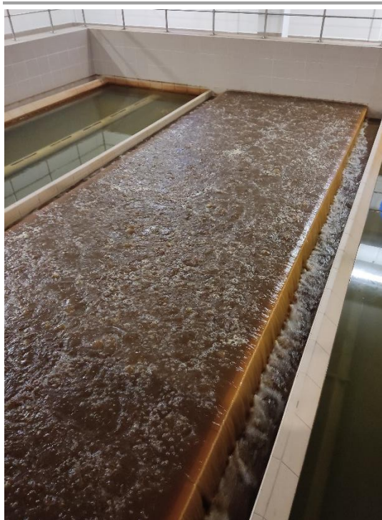
Obrázek 6.5 Pískový filtr při praní
