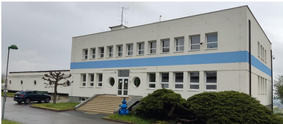
Obrázek 6.1 Úpravna vody Hosov
