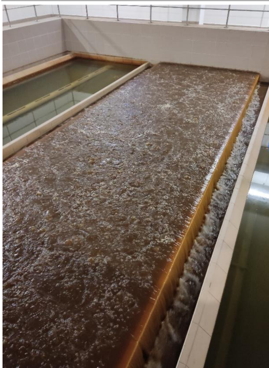
Obrázek 6.5 Pískový filtr při praní
