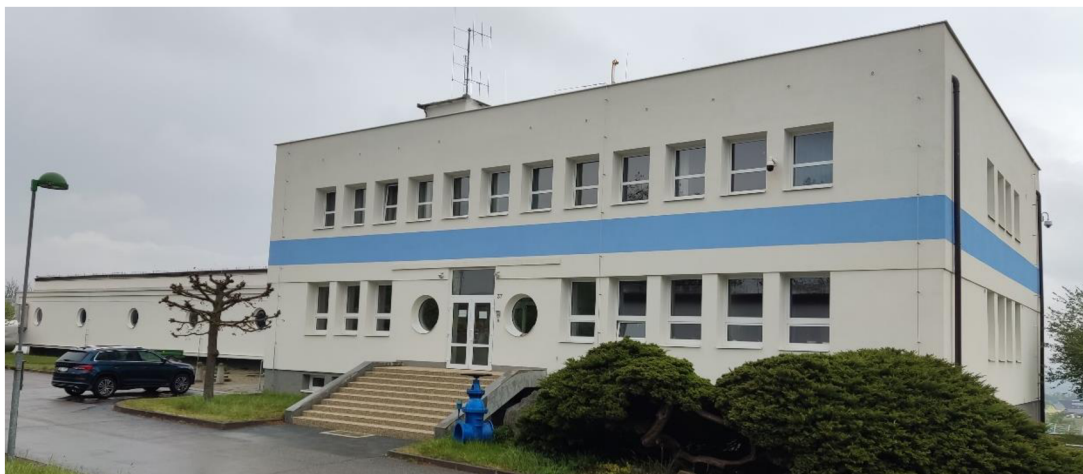
Obrázek 6.1 Úpravna vody Hosov
