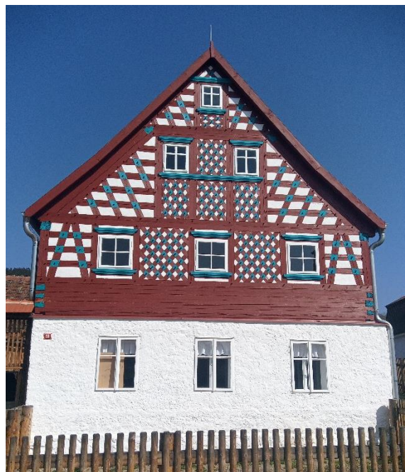
Obrázek 2: Příklad typického hrázdění v tzv. Chebském stylu, Statek Milíkov č. p. 18. (Soukromý archiv autora práce)
