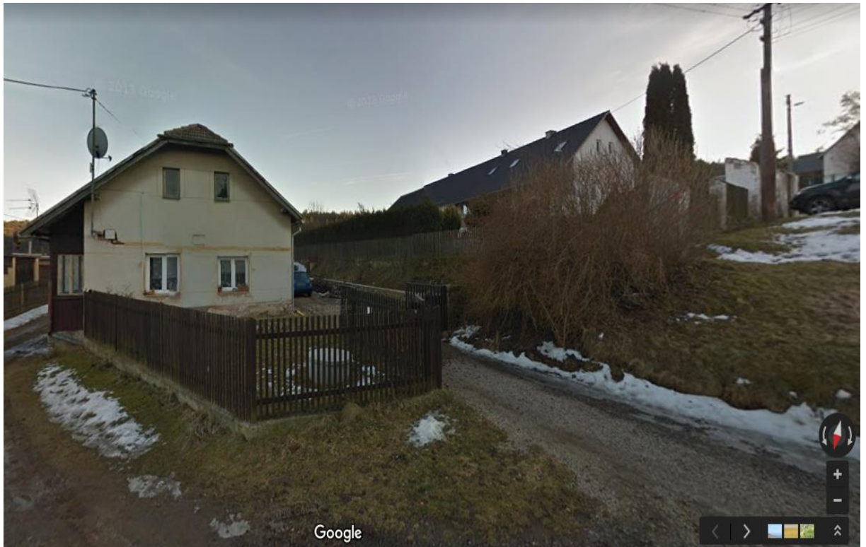
Obr. č. 37 Vlastní pohled na dům
