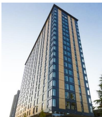
Obrázek 17: Ukázka Brock Commons Zdroj: (naturally:wood 2022)
