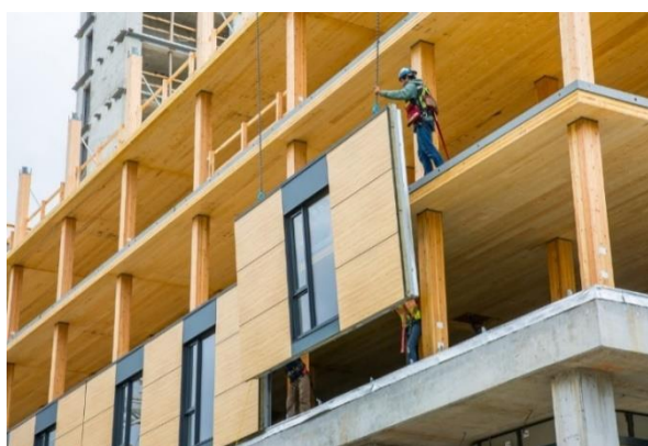
Obrázek 16: Ukázka montáže panelů Zdroj: (naturally:wood 2022)
