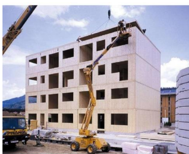
Obrázek 5: ukázka montáže budovy, Zdroj: (slideshare.net)
