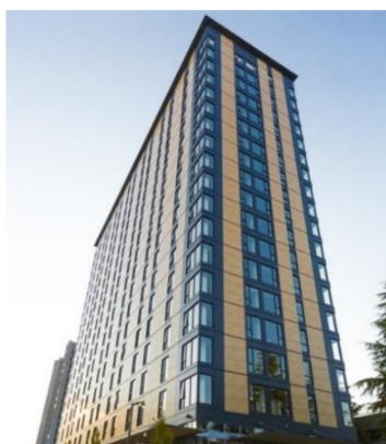
Obrázek 17: Ukázka Brock Commons Zdroj: (naturally:wood 2022)
