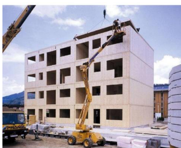
Obrázek 5: ukázka montáže budovy, Zdroj: (slideshare.net)
