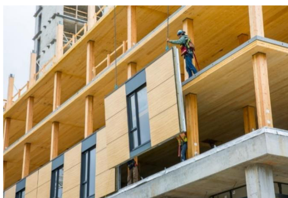
Obrázek 16: Ukázka montáže panelů Zdroj: (naturally:wood 2022)
