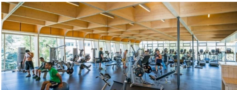
Obrázek 28: Ukázka stropu z CLT kazet, Zdroj: (McFarland Marceau Architects 2022)
