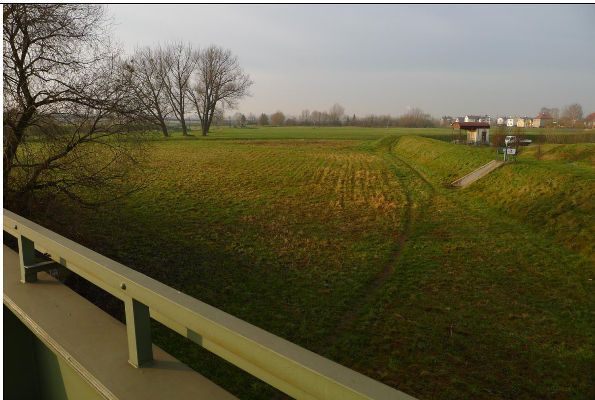
Foto 73: Pohled na nivu z železničního mostu, vpravo protipovodňová hráz podél Kateřinského potoka
