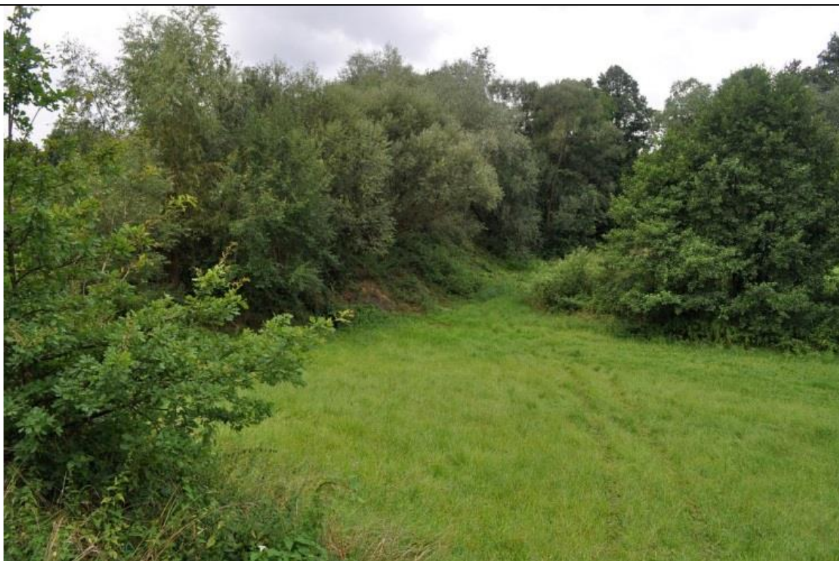
Foto 86: Louka navazující na hráz vodní nádrže Sedlinka (vlevo)
