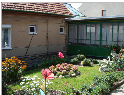
Obr.8.: Pohled na pravý roh v dolní části zahrady
