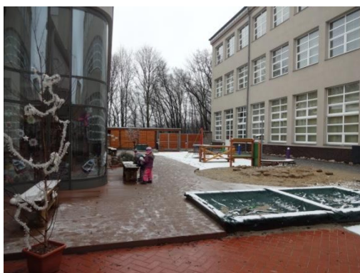
Obrázek č. 21 – Budova MŠ
