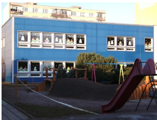
Obrázek č. 5 – Budova MŠ
