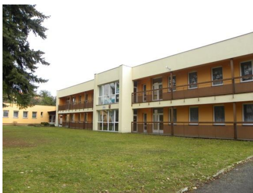
Obrázek č. 9 – Budova MŠ
