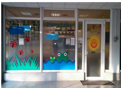
Obrázek č. 17 – Budova MŠ
