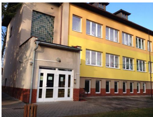
Obrázek č. 1 - Budova MŠ
