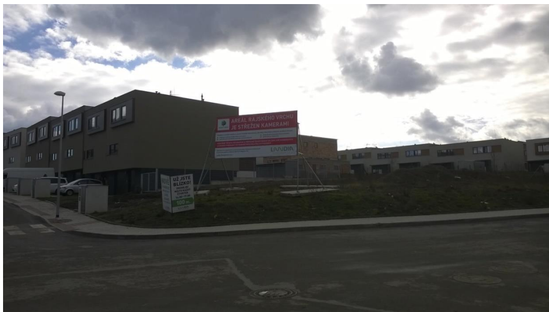
Obrázek č. 47: Pohled na již postavené řadové domy (zdroj: autorka)
