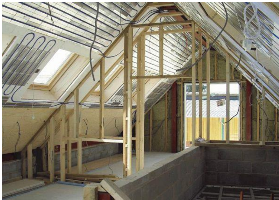
Obr. 8.3 Provedení stropního vytápění v praxi (23)
