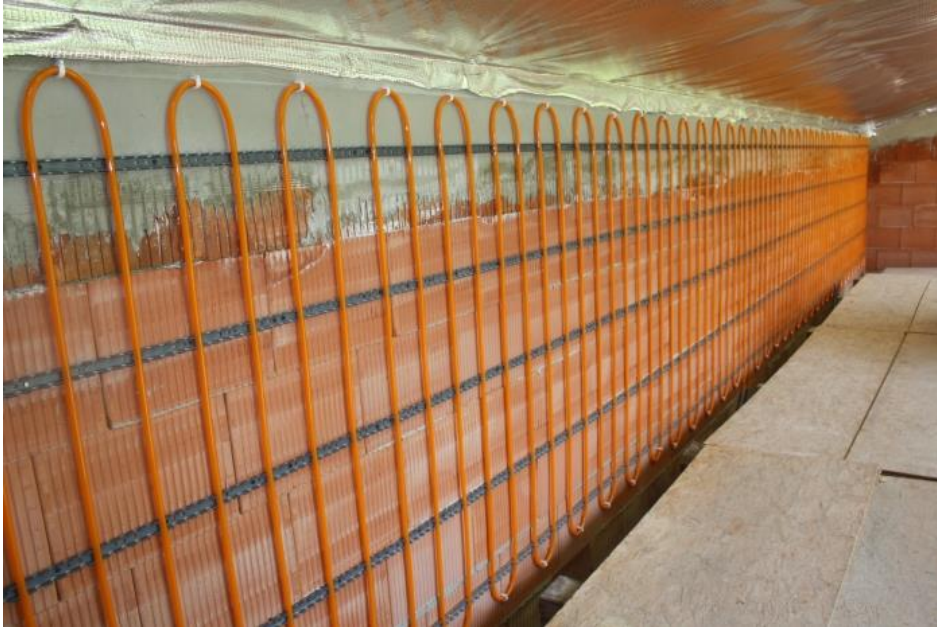
Obr. 8.2 Provedení stěnového vytápění v praxi (22)
