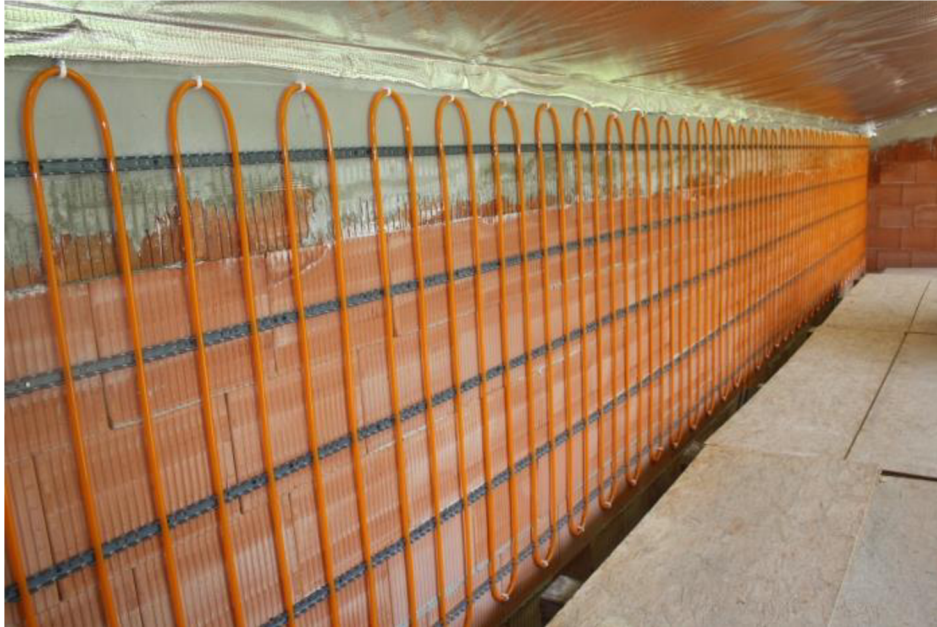
Obr. 8.2 Provedení stěnového vytápění v praxi (22)
