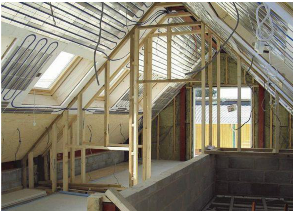
Obr. 8.3 Provedení stopniho vytápění v praxi (23)
