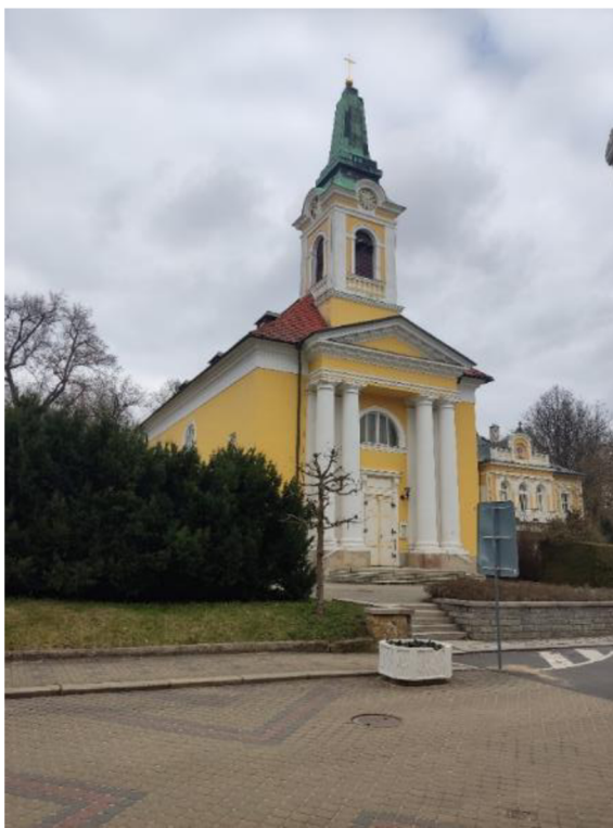
Obrázek 35: Katolický kostel Povýšení svatého Kříže. Zdroj: autor (2024).
