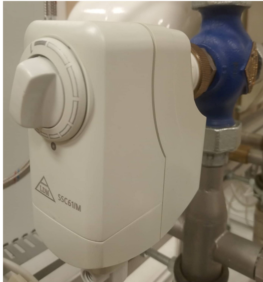
Obr. 1.4: Ventil se servopohonem
