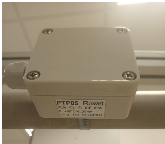
Obr. 1.6: Příložný teplotní snímač PTP05 od firmy Rawet[8]
