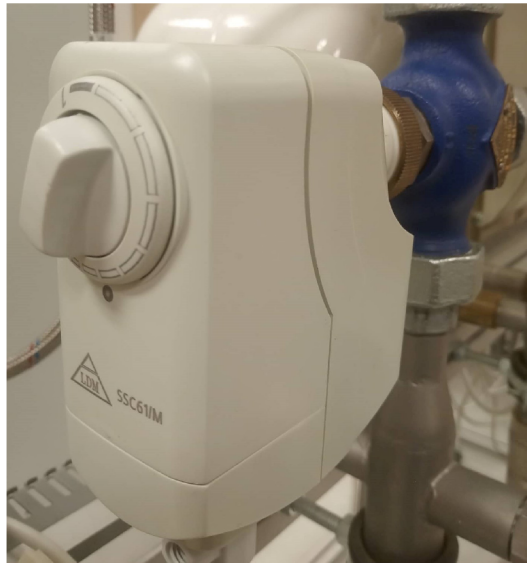
Obr. 1.4: Ventil se servopohonem
