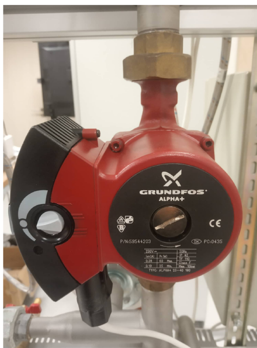
Obr. 1.3: Oběhové čerpadlo Grundfos
