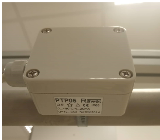
Obr. 1.6: Příložný teplotní snímač PTP05 od firmy Rawet[8]
