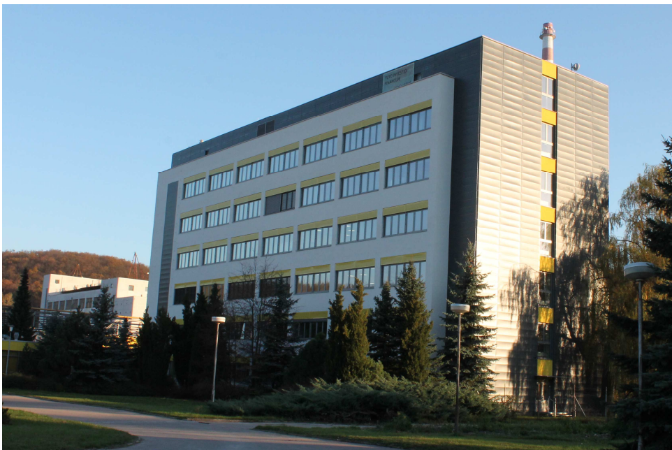
Laboratorní budova společnosti BioVendor – Laboratorní medicína a.s.
