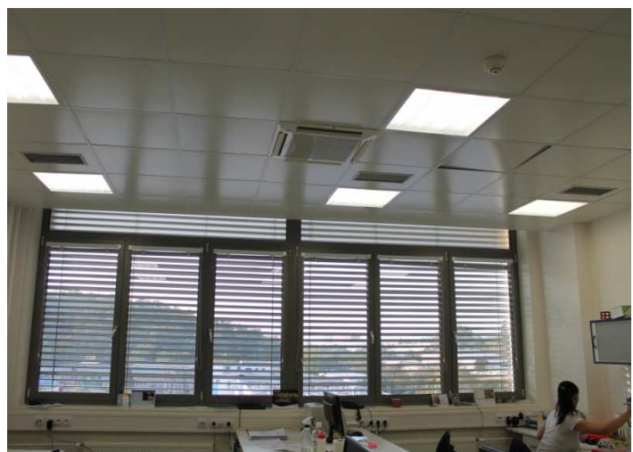
Umístění přívodních distribučních elementů VZT
